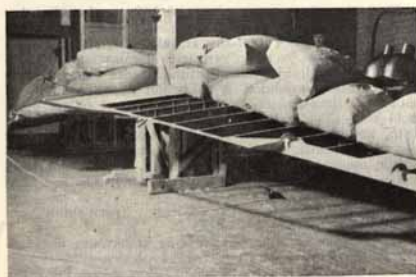
Siiven taipumaa määrättäessä kuormitettiin se ns. varmalla kuormalla. Siipi tuettiin keskeltä ja sen päälle kasattiin ilmoavimien jokautumisen mukaisesti yht. 1.240 kg hiekkasäkkejä. Valok. Mellen.
